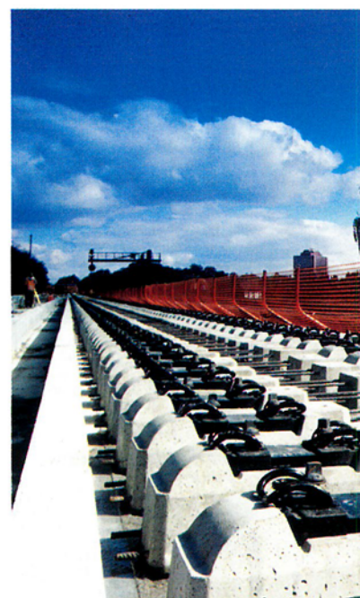
Bild 2: Zweiblock-schwellen B 355 TS im Betontrog
