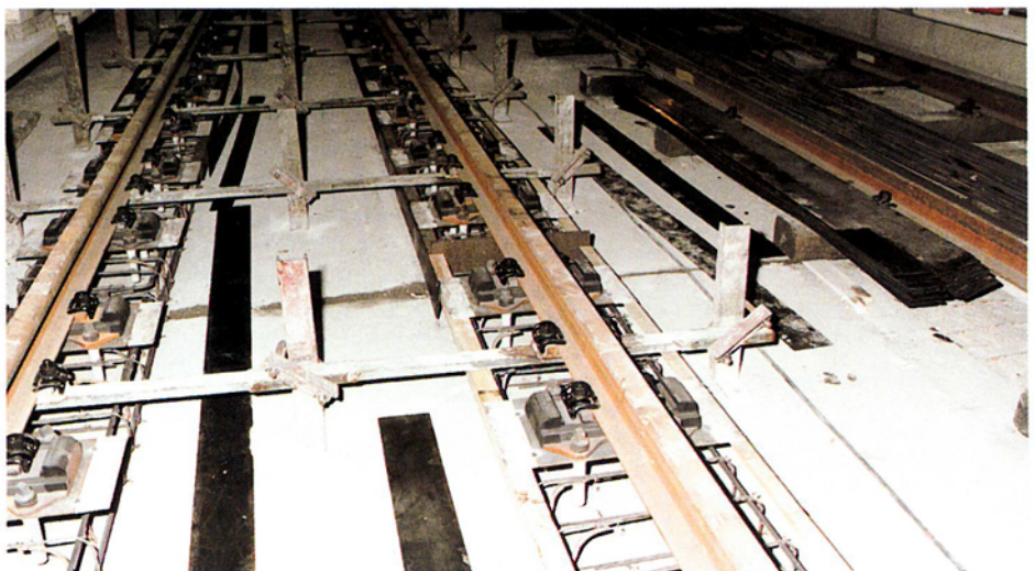
Bild 1: Bettungsloses Gleis vor dem Einschalen. Das Gleis ist feingerichtet und festgelegt
