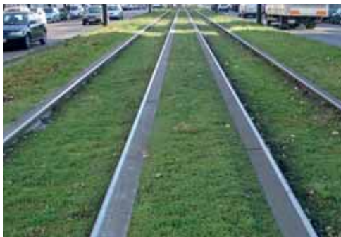
Abbildung 13: Ausführungsformen von Gleisbegrünungen (Grafiken: [28], Fotos: [32], [25], [32])
