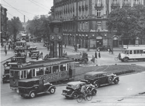
Abbildung 1: Rasengleise am Potsdamer Platz, Berlin 1933 (Foto: [20])
