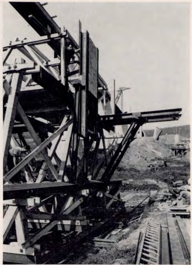
Bild 7. Klappbares Seitenteil des Lehrgerüsts für den Straßenbrückenteil einer Doppelstockbrücke
