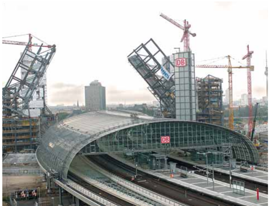
Nach Gewitternacht senken sich am Morgen des 30. Juli die Bügelbrücken
