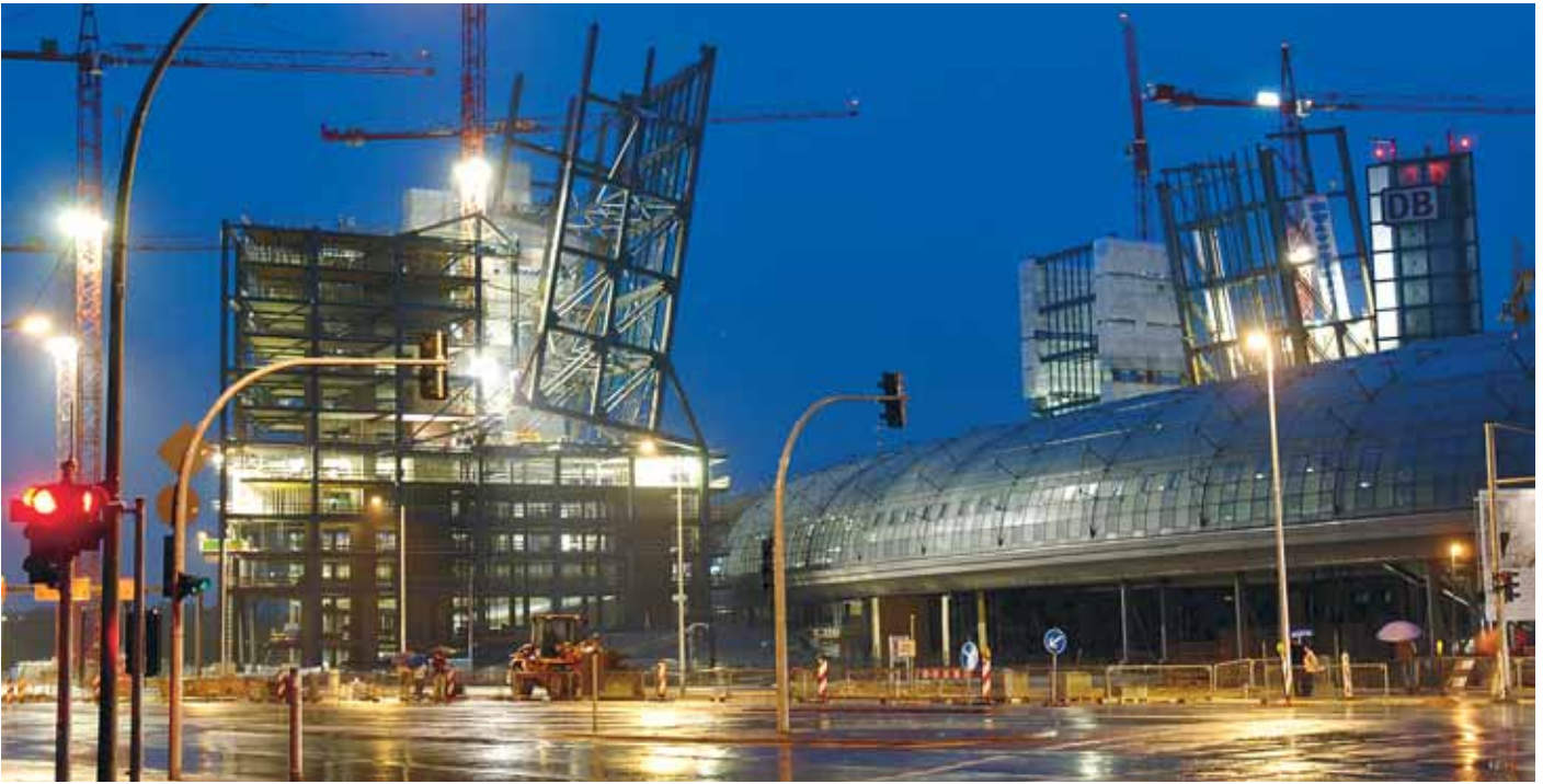
29. Juli 2005, kurz vor 22 Uhr: Die westlichen Bügelbrücken sind zum Absenken bereit.
