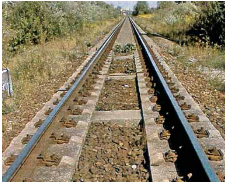
Abbildung 1.4: Bauart Fertigteilrahmen und Fertigteilplatte Bauart Karlsfeld
