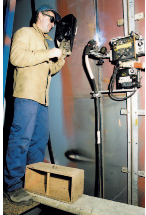
Bild 2.6-8: Teilmechanisierte vertikale Stumpfstoßschweißung
