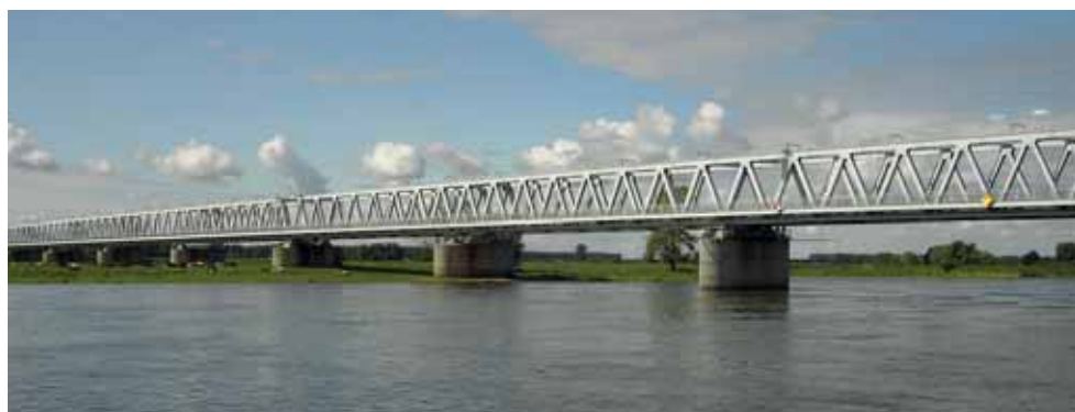
Stahlfachwerkbrücke, Inbetriebnahme 1987. Sie wurde neben der Hilfsbrücke erbaut, die nach Zerstörung der alten Flussstahlbrücke vorläufig den Eisenbahnverkehr übernommen hatte.
