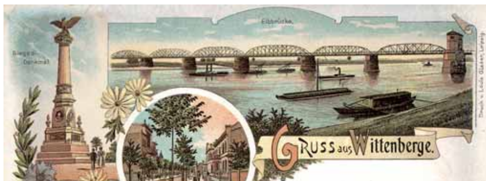
Fachwerkbrücke aus Flussstahl, erbaut 1883/84 als Ersatz für die Holzbrücke. Sie wurde im letzten Kriegsjahr 1945 gesprengt und zunächst durch eine Hilfsbrücke ersetzt.
