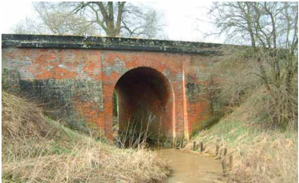
Bild 1.4: Einzelgewölbe in Ziegelmauerwerk über einen Bachlauf im Bayerischen Wald, gebaut 1856
