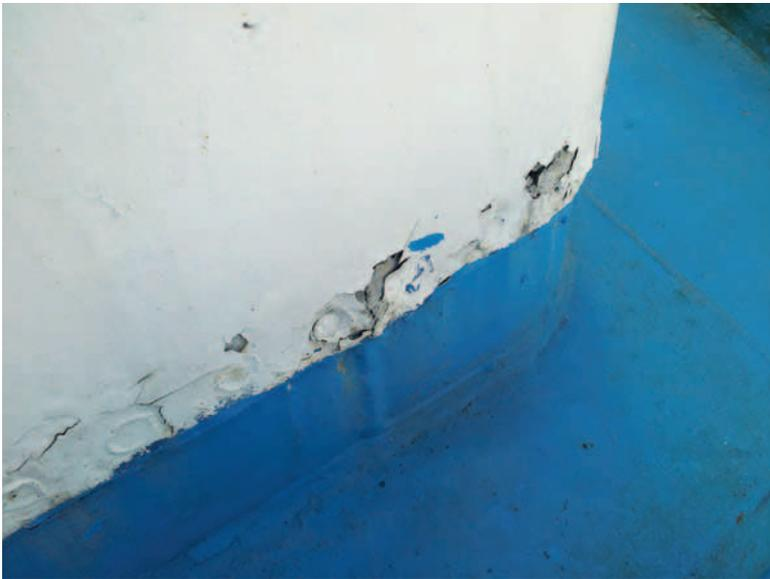
**Abb. 1.7: Galvanische Korrosion eines Aluminiumaufbaus auf Stahl**
