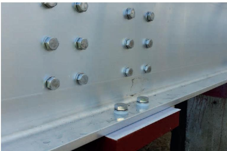
**Abb. 1.8: Edelstahlschrauben in Aluminiumlegierung und in Stahl**
