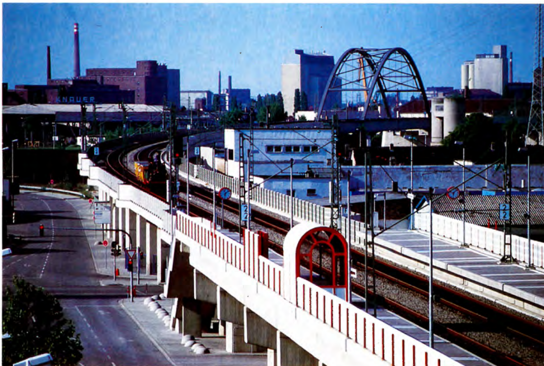
Bild 3: Schallschutzanlagen am Haltepunkt Mannheim-Handelsbahnhof
